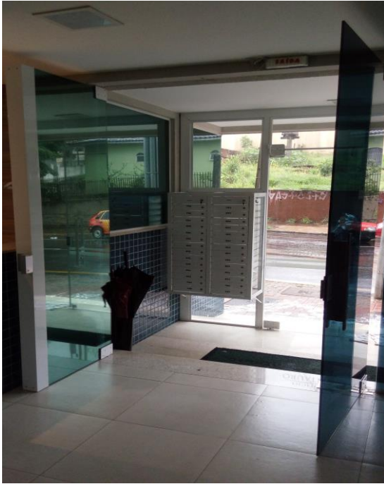
Imagem 8 – Porta de saída da edificação
