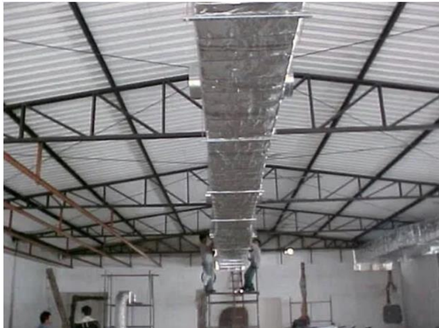
Figura 14 - Instalação de um sistema Dutado
