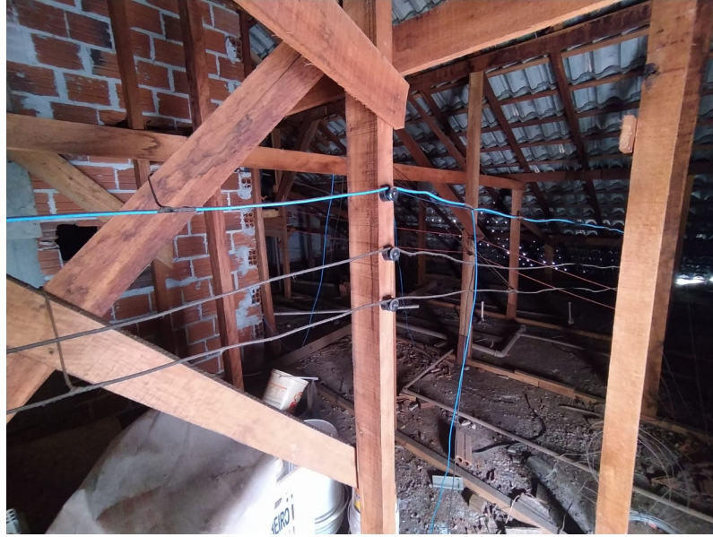
Foto 5 – Método de instalação dos condutores na laje
