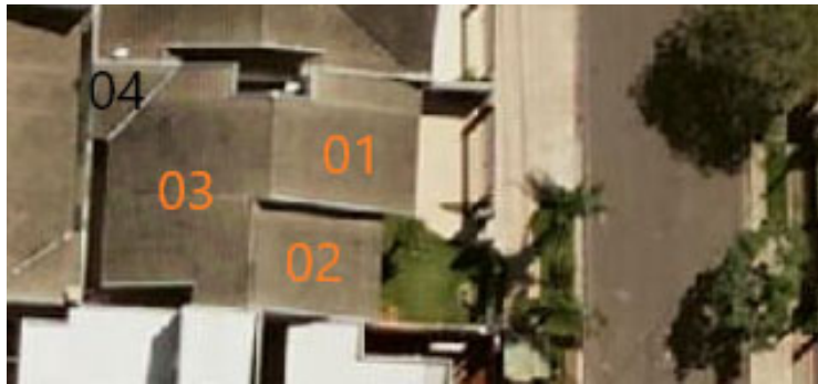
Foto 2 – Identificação das faces do telhado da residência
