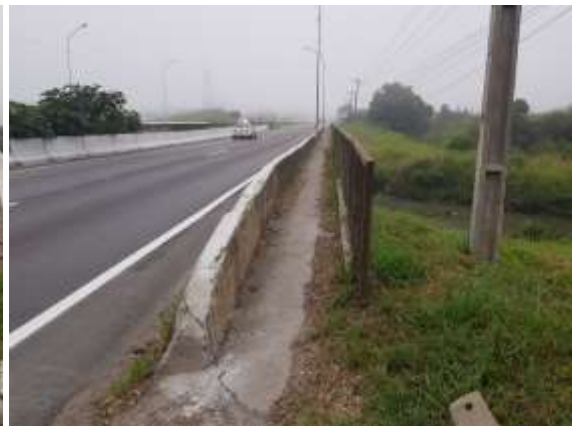
Imagem 5 – Passeio e guarda corpo metálico
