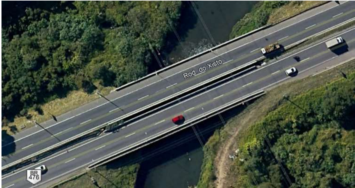
Imagem 1 - Ponte sobre o Rio Barigui – BR 476, Km 147,3.
