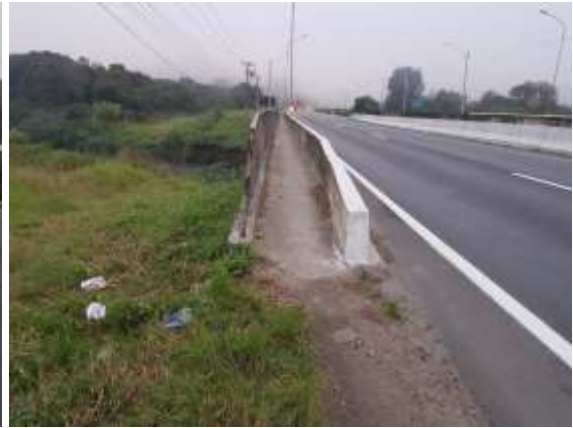
Imagem 3 – Passeio e guarda corpo metálico
