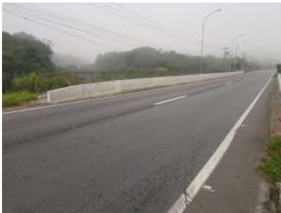
Imagem 4 – Vista da barreira new Jersey
