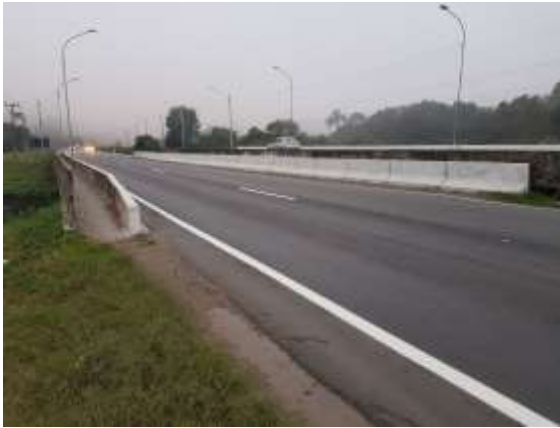
Imagem 2 - Vista da barreira new Jersey
