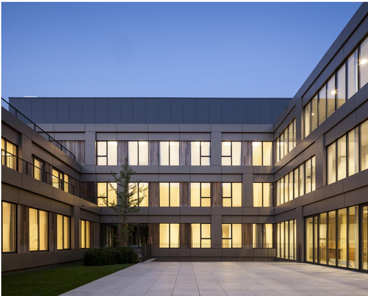
Figura 05: Vista do jardim interno.
