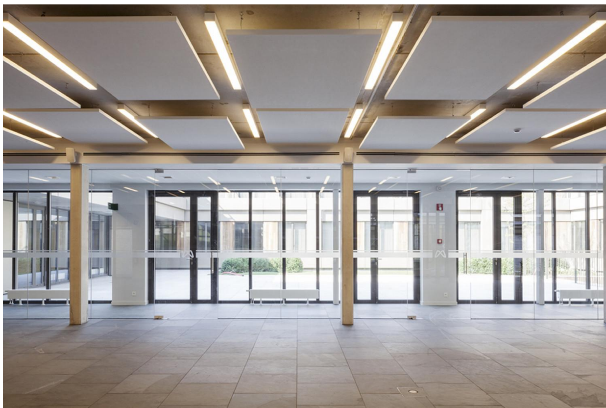
Figura 10: Interno da edificação.
