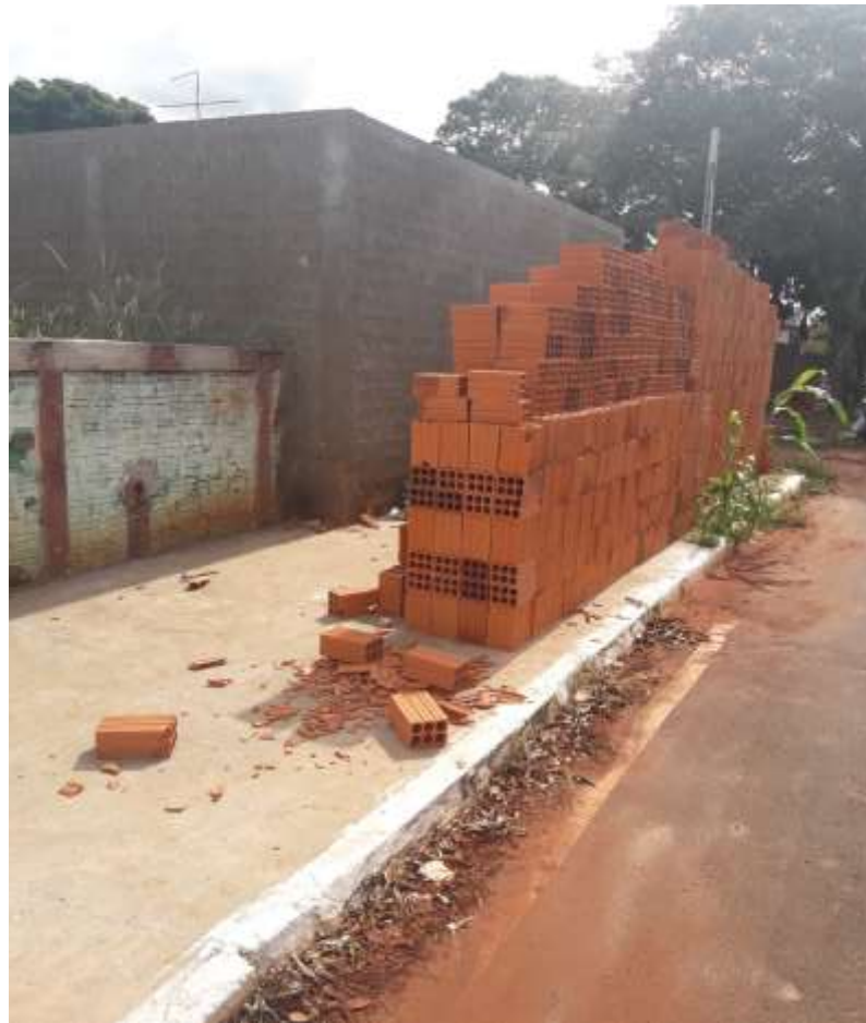
Imagem 7 – Descarga dos tijolos cerâmicos
