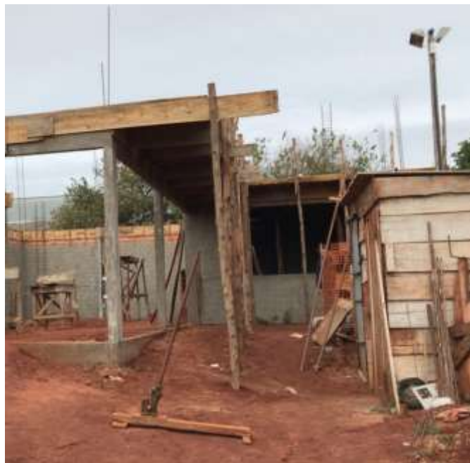
Imagem 8 - Local de guarda de materiais
