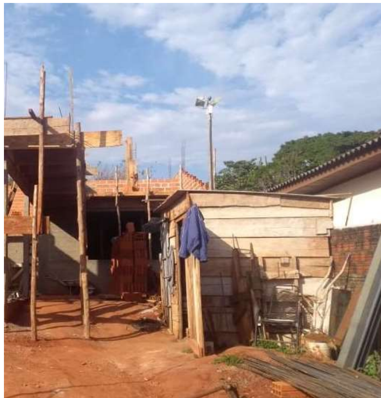
Imagem 10 – Local de descarga do aço
