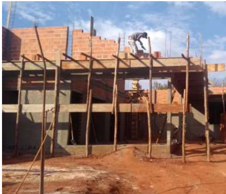
Imagem 9 – Alvenaria do pé direito duplo e eitão
