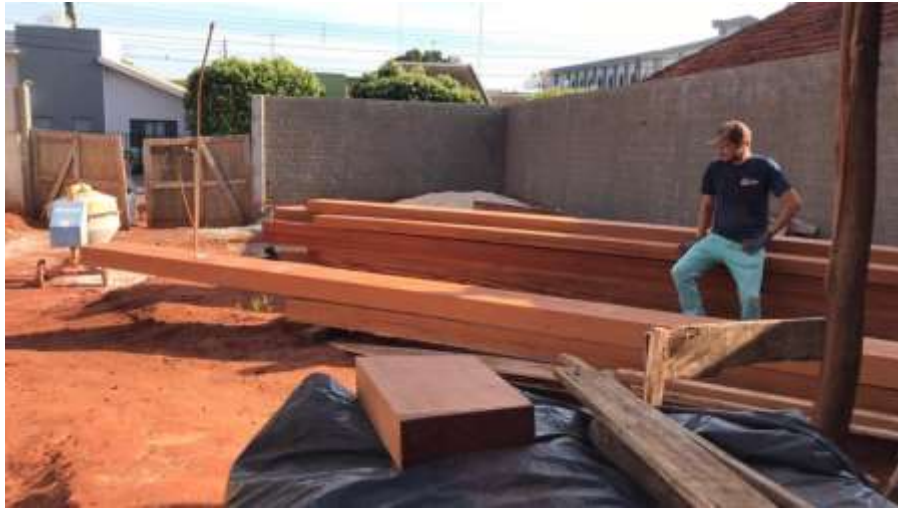
Imagem 19 – Vigas estruturais em madeira
