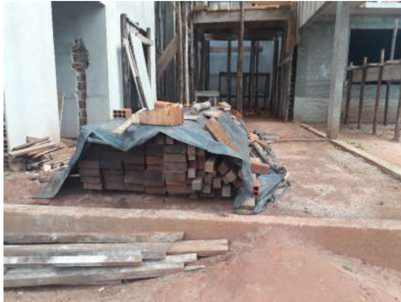
Imagem 12 – Local de descarga das vigas e caibros
