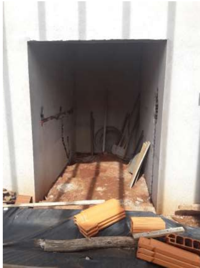
Imagem 16 – Local para guarda de ferramentas
