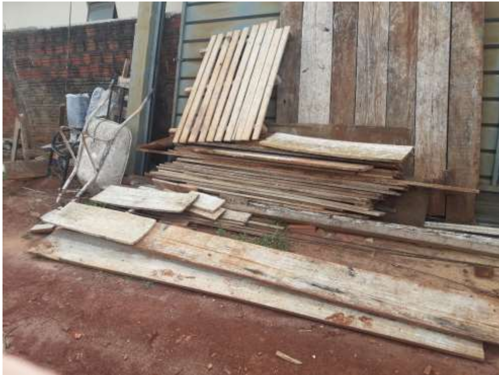
Imagem 17 – Tábuas empilhadas próximo a obra
