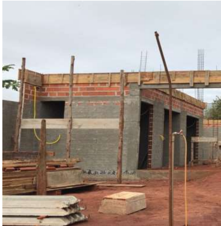
Imagem 11 – Local de descarga das tábuas para a caixaria
