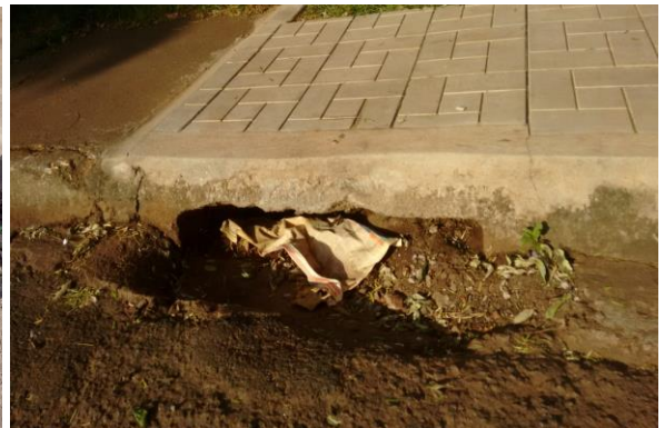
Foto 8 - Boca de lobo obstruído por lixo
