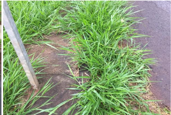
Foto 6 - Boca de lobo obstruído por grama
