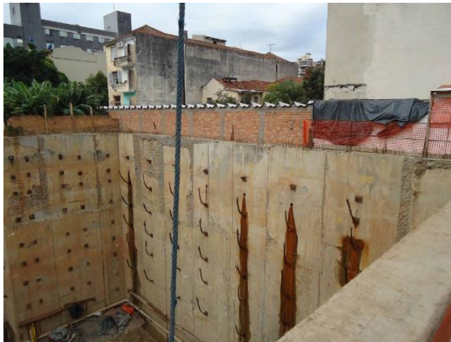
Figura 4 –Exemplo de parede de contenção diafragma
