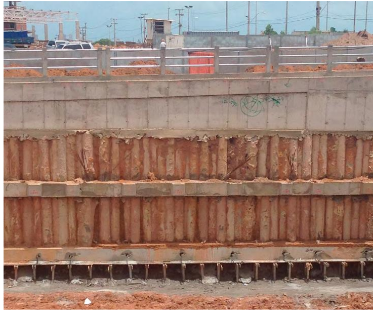
Figura 5 –Exemplo de parede de contenção estaca secante
