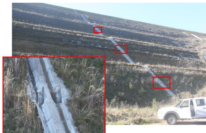
Figura 13 – Exemplo de drenagem transversal
