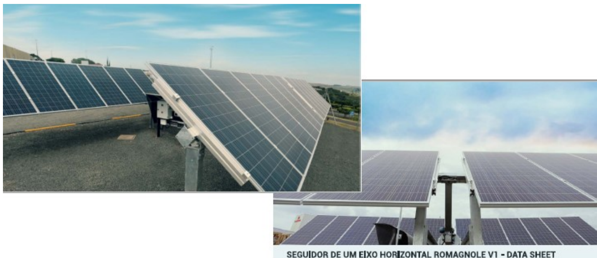
Figura 2 - Estrutura Tracker
