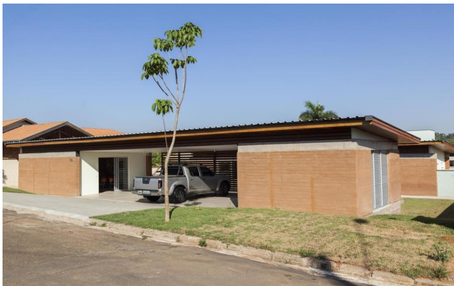
Figura 4: Fachada frontal da residência Casa Colinas feita em taipa de pilão.
