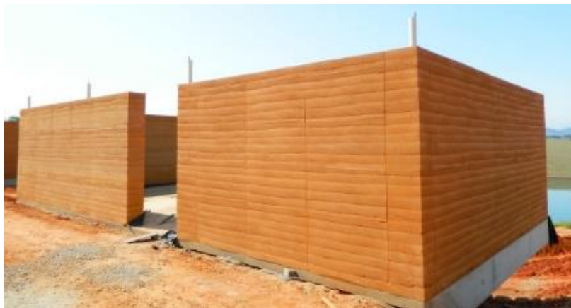
Figura 3: Construção feita com taipa de pilão. Fonte: Google Imagens.
