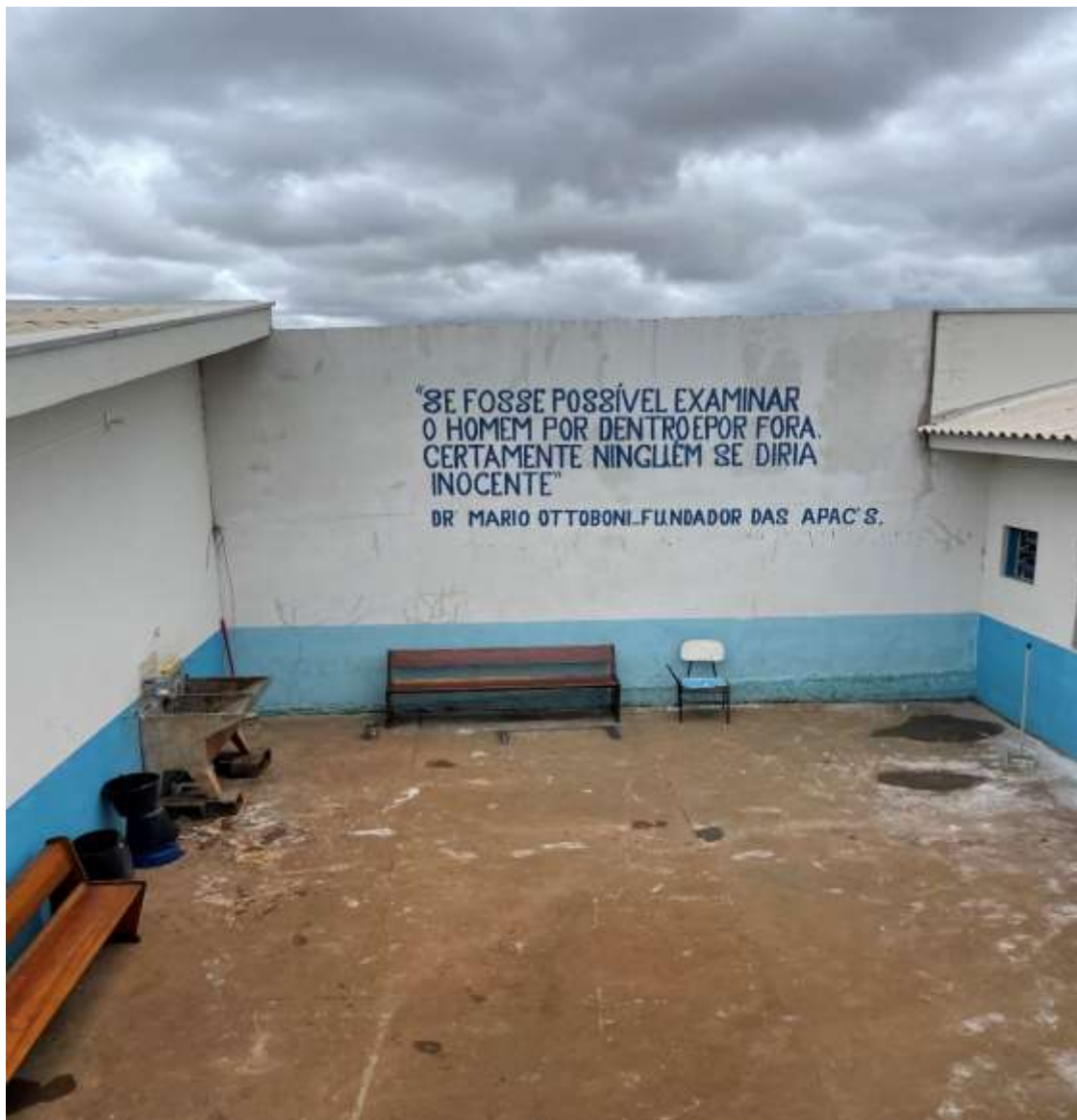
Figura 3 - Fotografia do pátio da galeria destinada ao cumprimento de pena no regime semiaberto do CRS da APAC de Ivaiporã, Estado do Paraná
