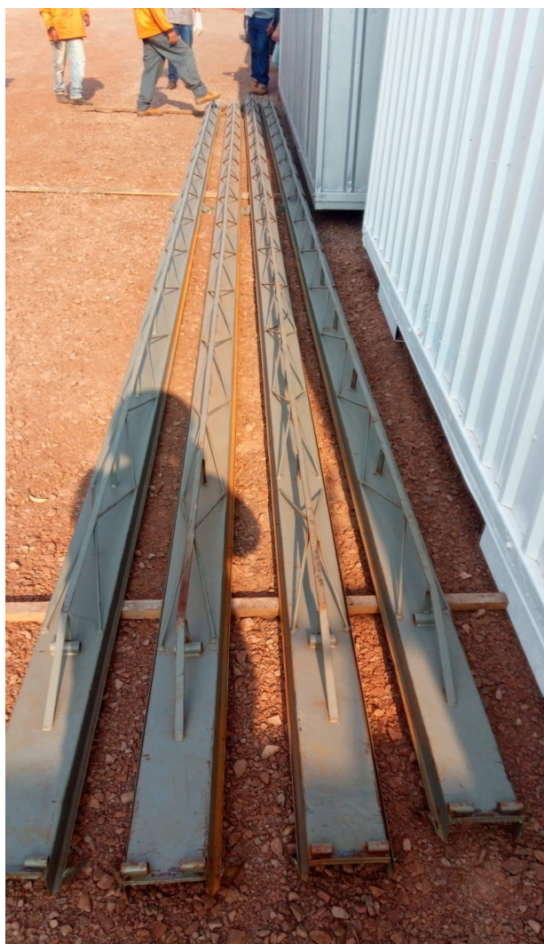
Figura 3 – Conjunto de 4 calhas treliçadas.
