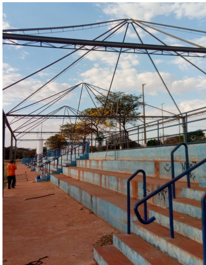
Figura 1 – Montagem de pavilhão com 3 tendas 10x10 (300m 2 ).
