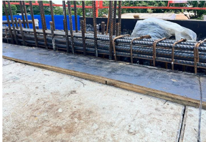
IMAGEM 3 – PEÇA DE MADEIRITE “ESTUFADA”
