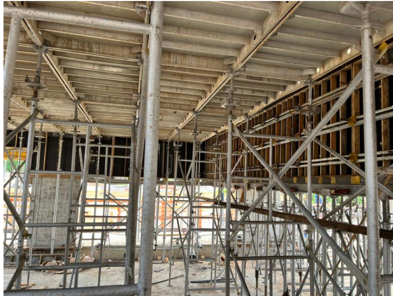
IMAGEM 7 – ESCORAMENTO METÁLICO IN LOCO
