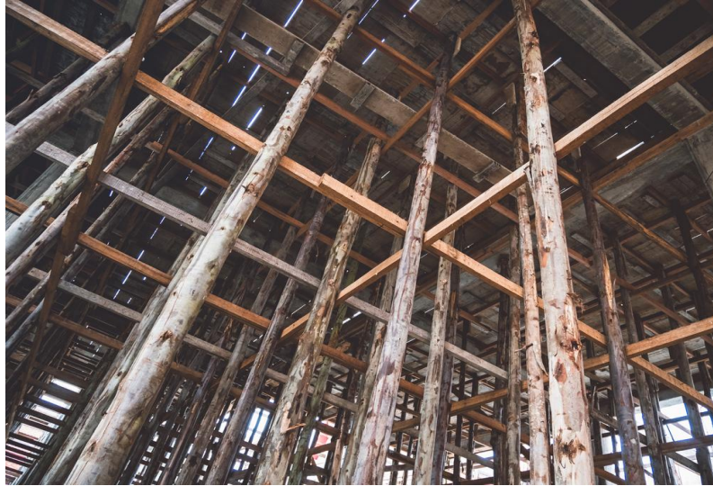
IMAGEM 5 - PORTAL CONSTRUÇÃO FÁCIL. Escoramentos, cimbramento e fôrmas.
