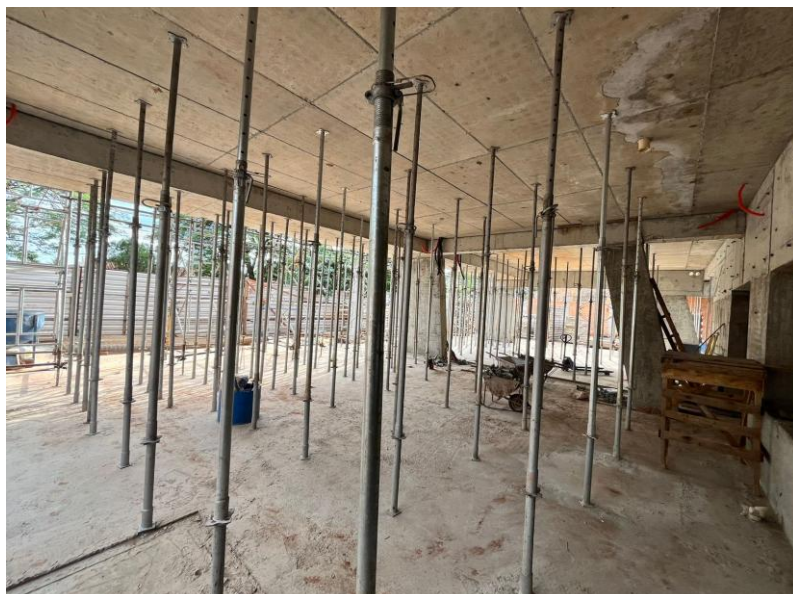
IMAGEM 6 – ESCORAMENTO METÁLICO IN LOCO
