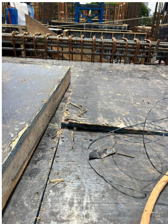
IMAGEM 1 - PEÇA DE MADEIRITE “ESTUFADA”
