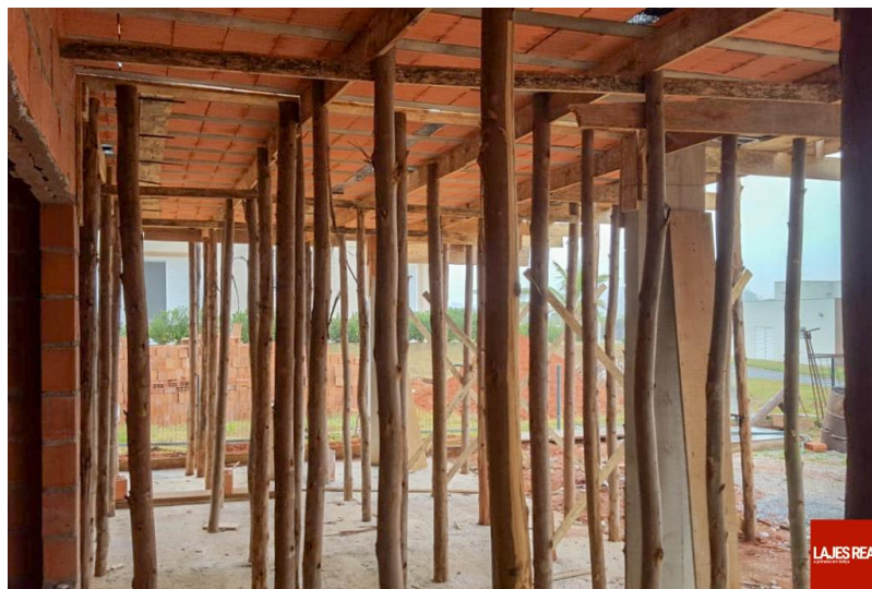
IMAGEM 4 - LAJES REAL. Escora de eucalipto
