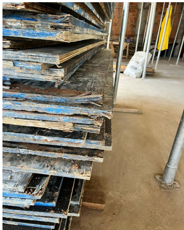
IMAGEM 2 - PEÇAS DE MADEIRITE “DESGASTADAS”
