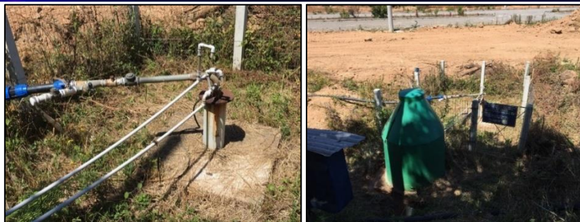
Figura 6 – Sistema de captação e tratamento do SAA Sede do M1 Fonte: Protásio Alves, 2021.
