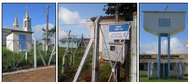
Figura 4 – Ponto de captação, tratamento e reservação de água no M1 Fonte: Muitos Capões (2022).
