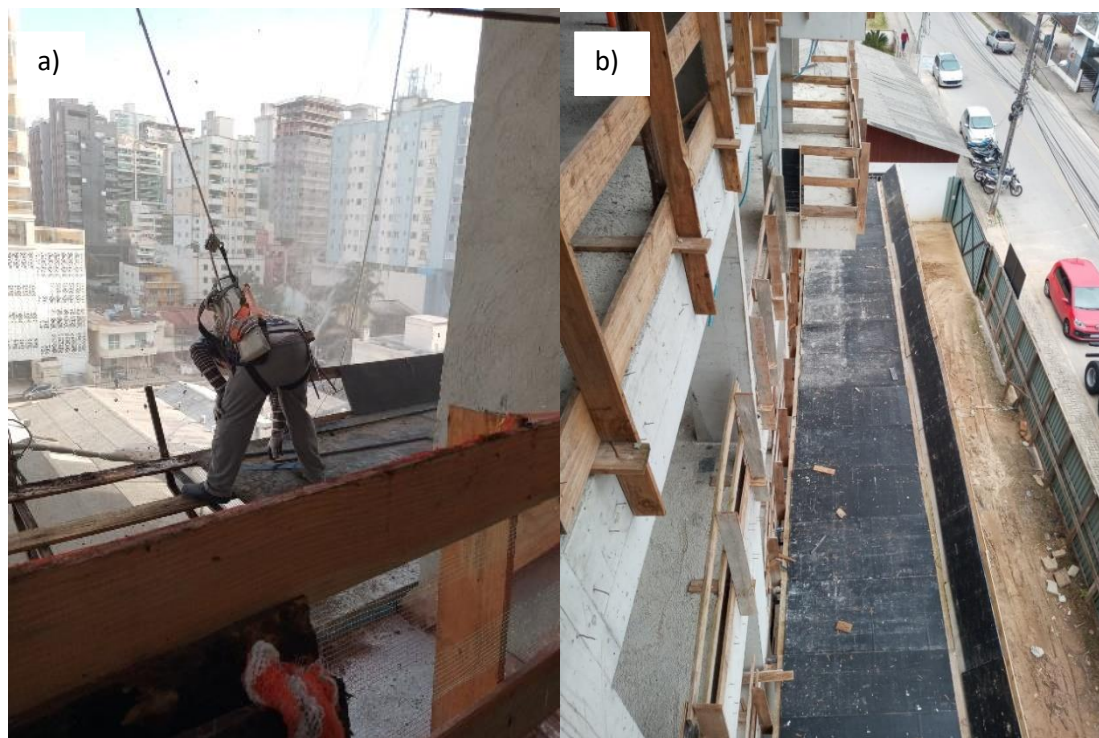
Imagem 4: Utilização dos Equipamentos de proteção
