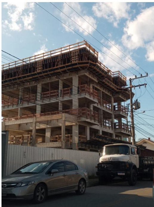
Imagem 1: Bandejas instaladas no edifício
