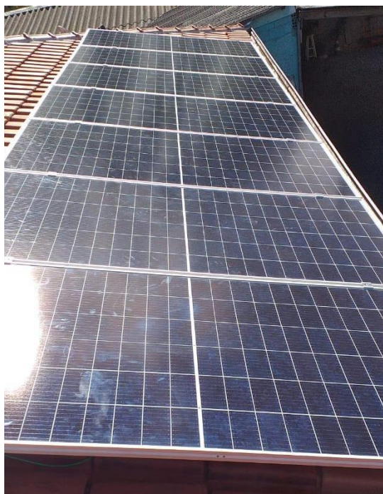
Figura 15 – Instalação dos Módulos Fotovoltaicos
