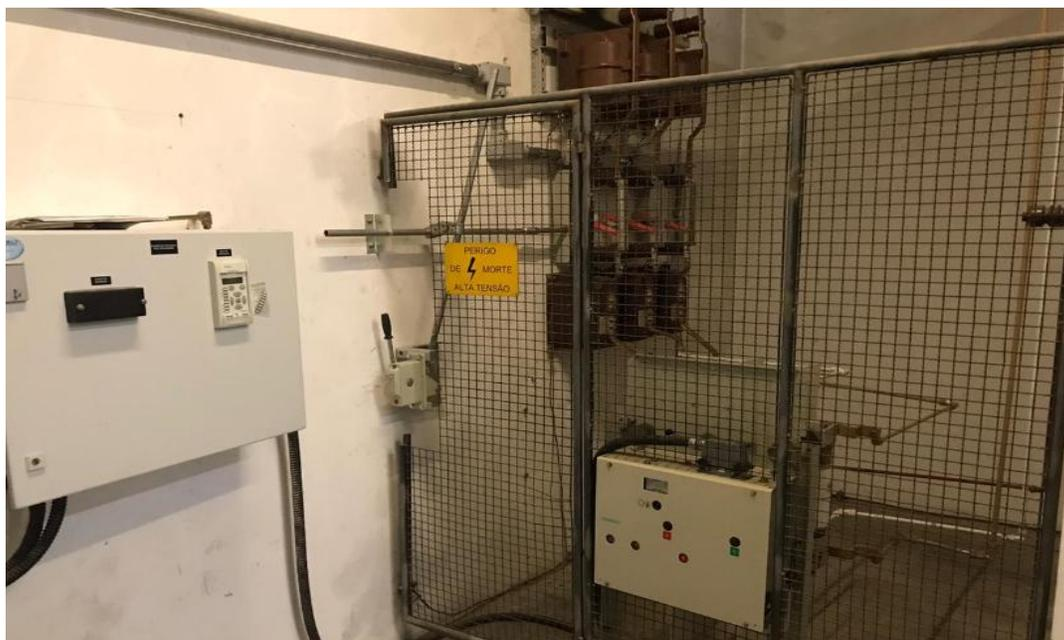
Figura 6- Disjuntor Geral de Média Tensão (fonte: do autor)
