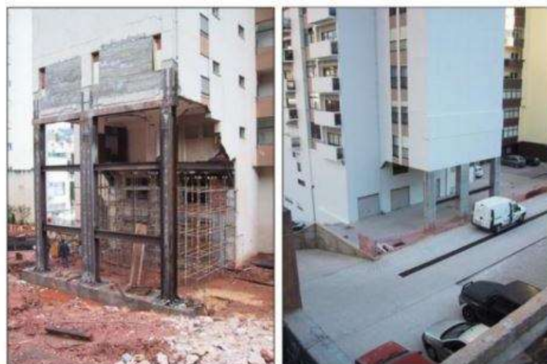
Figura 11 – Finalização do reforço e acabamento
