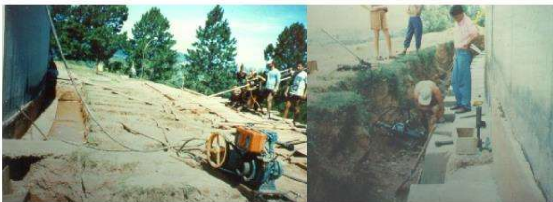
Figura 13 – Ancoragem das paredes do reservatório
