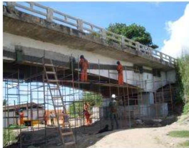
Figura 4 – Viga com protensão externa em suas laterais, com desvio dos cabos de protensão
