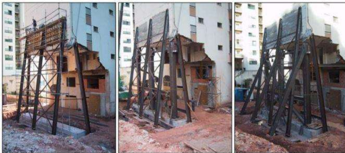
Figura 9 – Processos de escoras e execução de pilares metálicos
