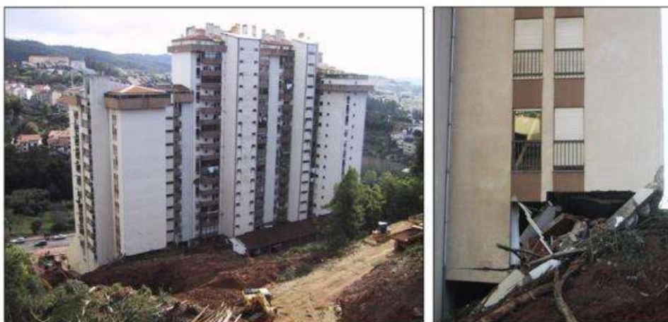
Figura 7 – Prédio que sofreu deslizamento, sofrendo danos em sua estrutura
