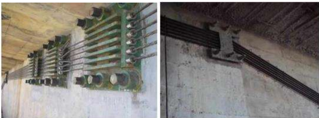
Figura 6 – Desviadores com traçado reto e poligonal
