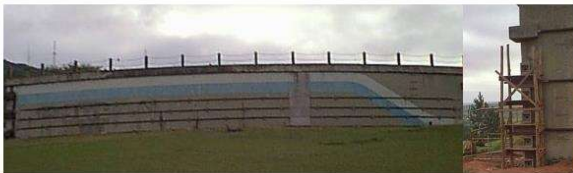
Figura 14 – Parede sul com protensão externa
