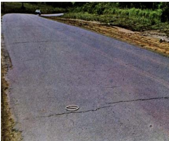
Figura 4: Trinças isoladas- transversal
