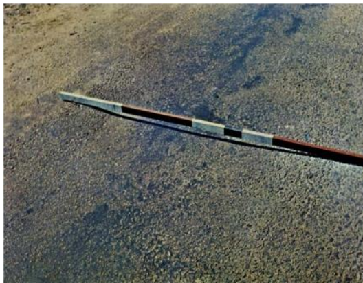
Figura 9: Afundamento local
