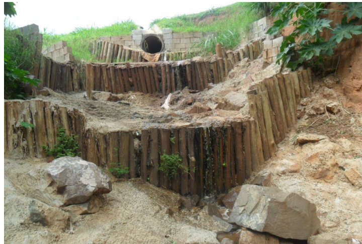
Figura 3 – Paliçadas instaladas em área degradada.
